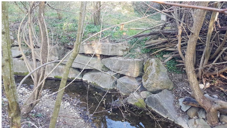
Uferverbauung mit Blocksteinen
